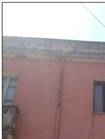
L'acqua proveniente dalla copertura viene convogliata in un foro che attraversa in tutto lo spessore il muretto d'attico e il cornicione.
