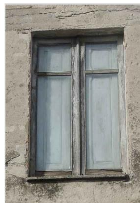
Finestra con infisso in legno composto da due ante di uguali dimensioni; ogni anta è ripartita da traversi orizzontali in due campi di diverse dimensioni. L'infisso è completo di scurini interni. Il davanzale è costituito da una lastra in materiale lapideo.
