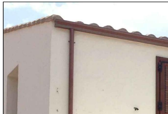
L'acqua proveniente dalla falda viene convogliata nel canale di gronda in materiale plastico. Successivamente il sistema è stato integrato con un discendente in materiale plastico.
