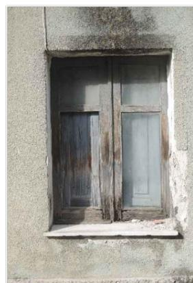
Finestra con infisso in legno composto da due ante di uguali dimensioni; ogni anta è ripartita da traversi orizzontali in due campi di diverse dimensioni. L'infisso è completo di scurini interni. Il davanzale è costituito da una lastra in materiale lapideo.
