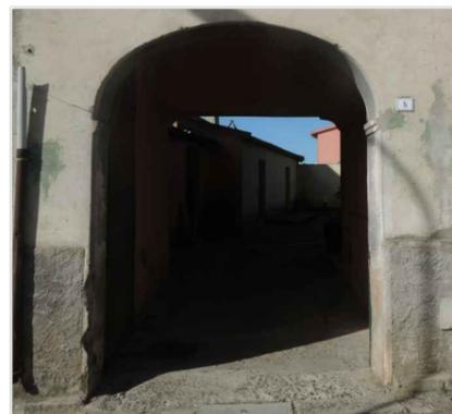
Portale costituito da due montanti intonacati presumibilmente costituiti da conci di pietra squadrata o da unico monolite, e arco policentrico, parzialmente intonacato/intonacato che non consente di conoscere il sistema statico dell'elemento. L'infisso è assente.
