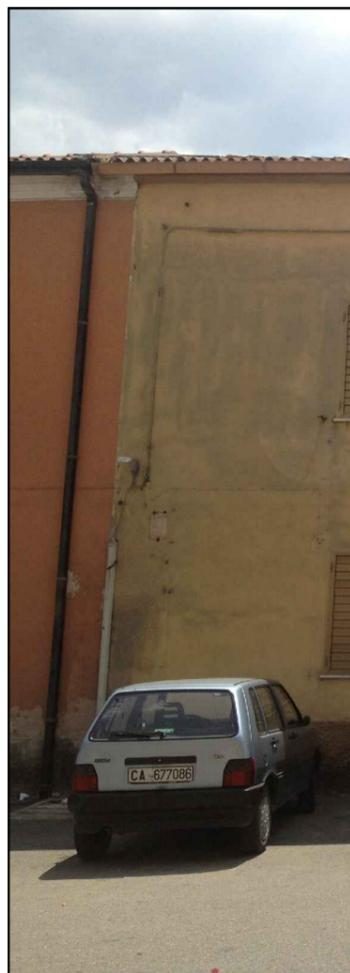
L'acqua proveniente dalla falda viene convogliata nel canale di gronda in materiale plastico. Successivamente il sistema è stato integrato con un discendente in materiale plastico con terminale in ghisa.
